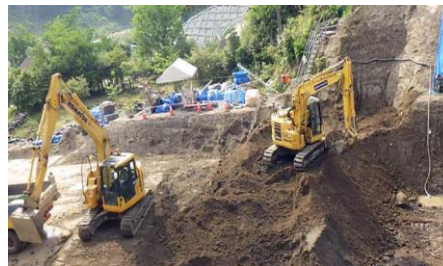
土砂崩れ現場の復旧工事（福岡県）
