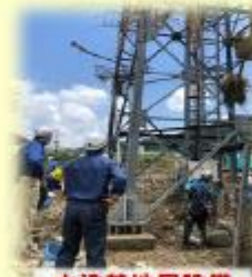
水没基地局設備 及び伝送路復旧
